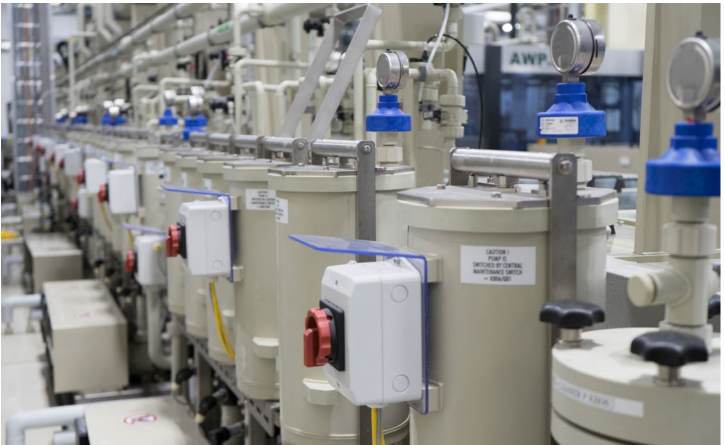
图 9：从上方供应循环水的管道、控制装置和传感器
