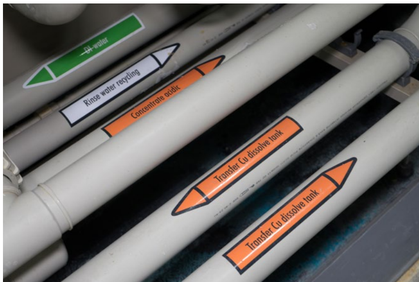
图 8：安美特的槽液转移管道可自动进行化学药品转换和维护
